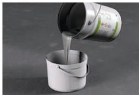
2. Benötigte Menge in sauberen Mischeimer abfüllen
