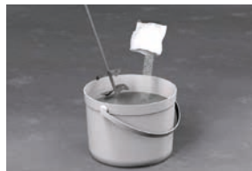
3. Katalysator (laut Mischtablelle, Temperatur- und Verarbeitungszeit) bei langsam laufendem Rührwerk zugeben und 2 Min. mischen. (Kleinmengen können auch von Hand gemischt werden)
